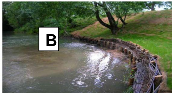
Figure 24 : Entretien (A) et protection par fascinage (B) de cours d'eau
