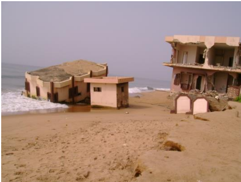
Figure 12 : Erosion côtière en Afrique de l'Ouest
