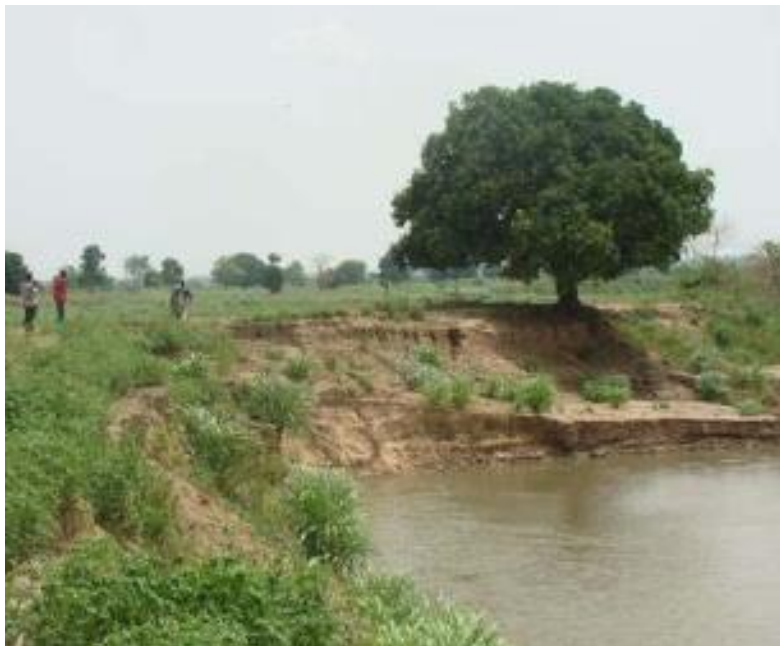
Figure 17 : La berge dégradée d'un cours d'eau
