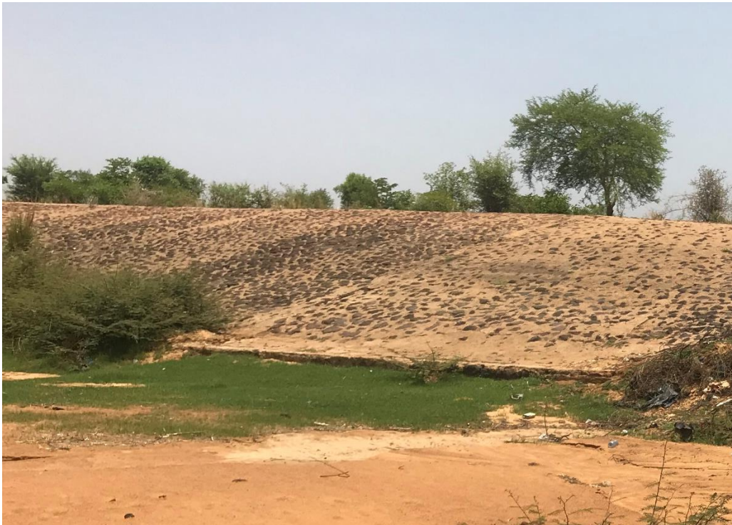
Figure 25 : Un exemple de protection mécanique de berge d'un cours d'eau
