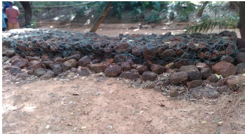
Photo 9 : Pose de gabions pour le contrôle de l'érosion hydrique dans la forêt classée du Kou
