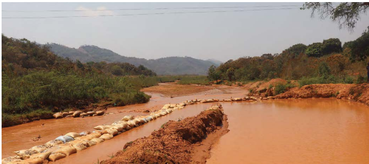
Barragens de rejeitos improvisadas feitas por mineiros artesanais em Penhalonga, Moçambique, numa tentativa de resolver o problema do comprometimento da qualidade da água devido a práticas mineiras insustentáveis na tri-bacia. Crédito da foto: Davison Saruchera
