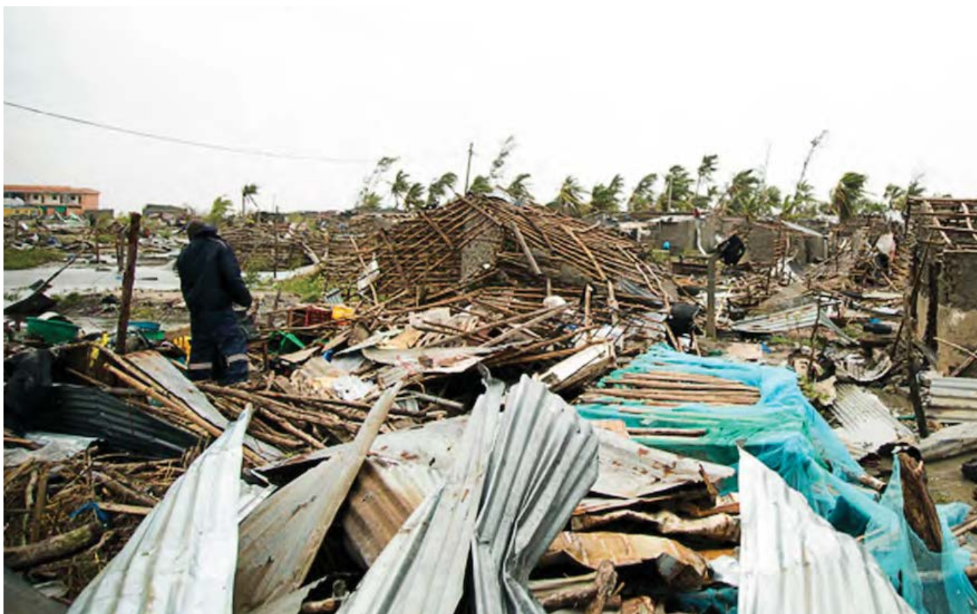
Um homem procura entre os escombros após o ciclone Idai, em março de 2019, na Beira, Moçambique. Muitas famílias ficaram sem casa depois de as suas casas terem sido destruídas pelo ciclone: Crédito da foto: Denis Onyodi/The Associated Press
