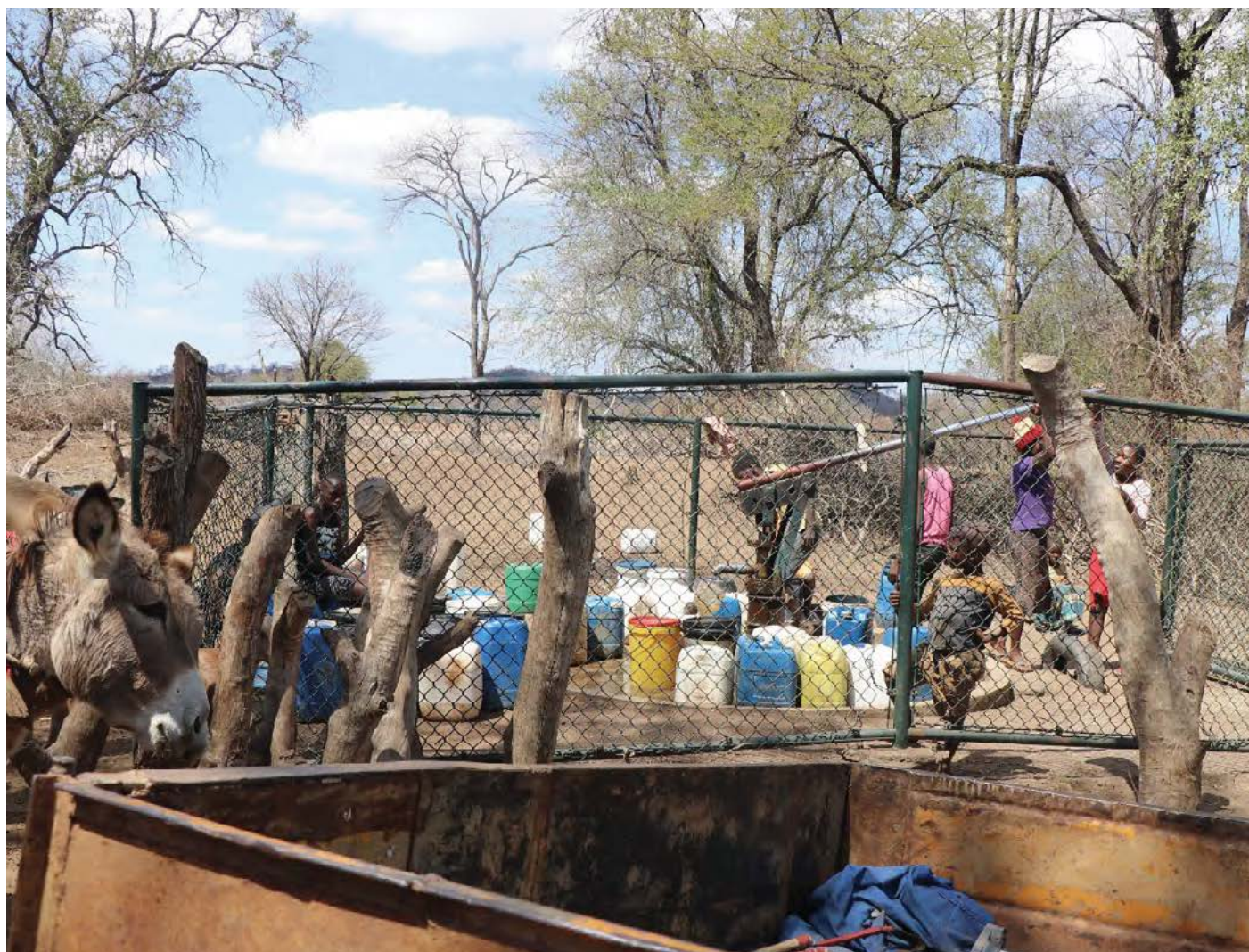
Furo comunitário em Chiredzi, Zimbabué, que fornece água a mais de 200 agregados familiares de três aldeias. Crédito da foto: GEF - Projeto BUPUSA
