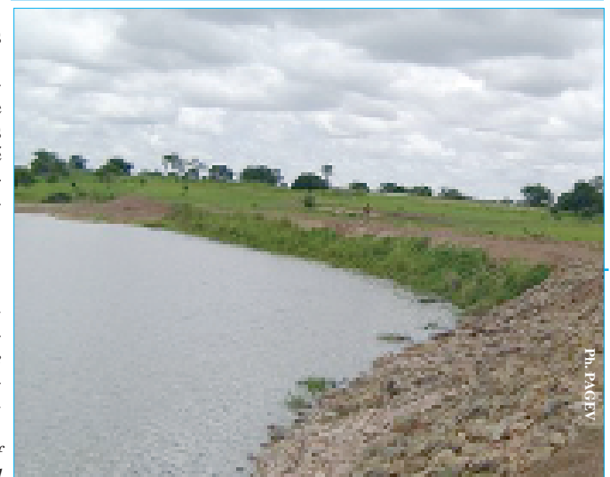
Figure 6 Barrage de Sakom après la réhabilitation
