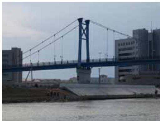
Работы по обустройству берегов реки Урал в городе Атырау
