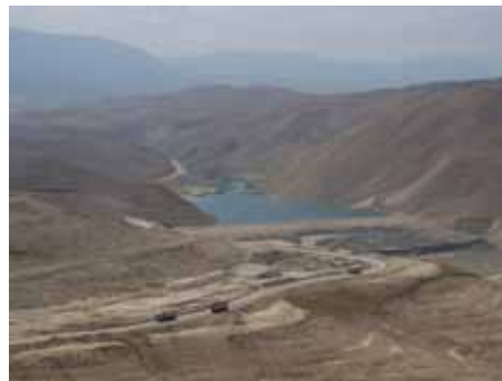
Строительство нового водохранилища с плотиной высотой 150 метров
