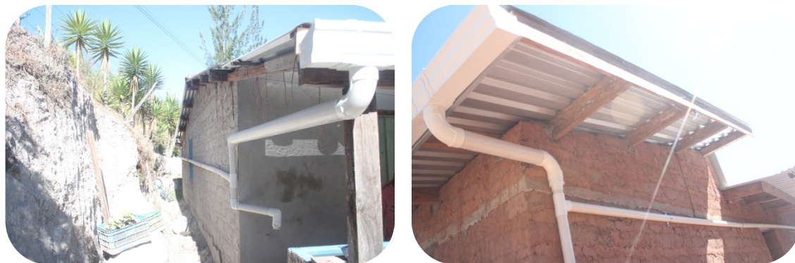
Imagen 8. Instalación de sistemas de captación de agua lluvia
