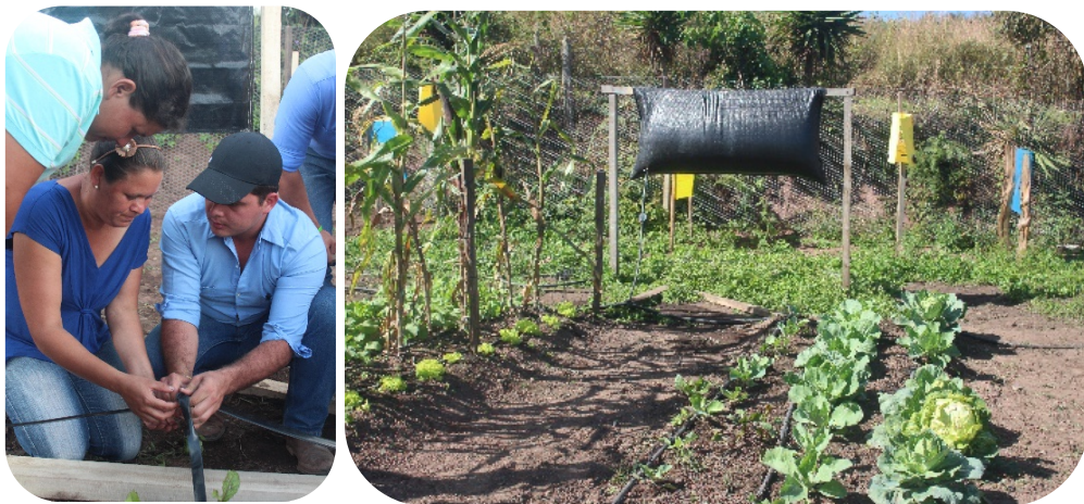
Imagen 7. Instalación del sistema de riego en la parcela demostrativa
