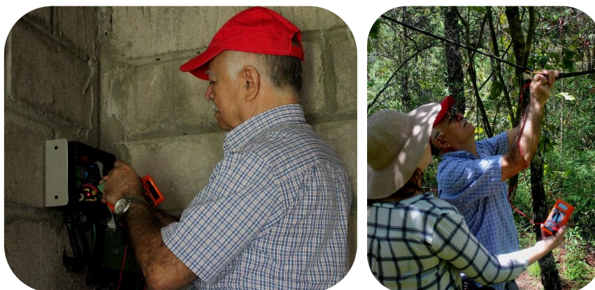
Imagen 1. Reparación del sistema solar de distribución de agua
