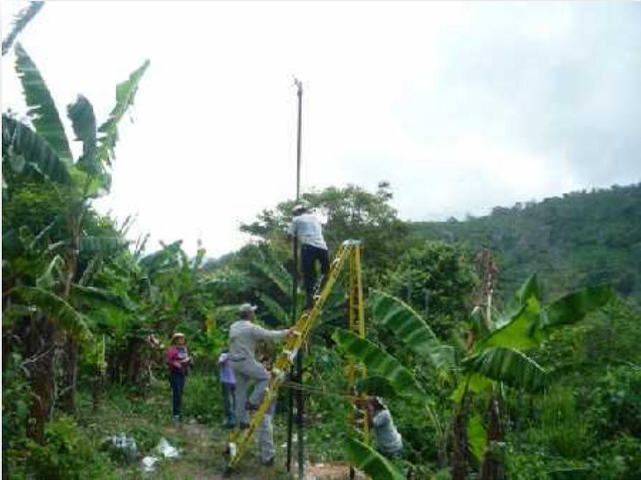
Fotografía 4. Instalación de un anemómetro y veleta en el sitio seleccionado en la Comunidad de Jaguito.
