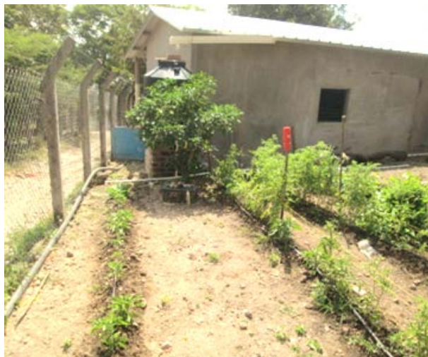
Foto 1: Instalación sistema cosecha de agua, octubre 2014. CEPRODE/GWP EL SALVADOR
