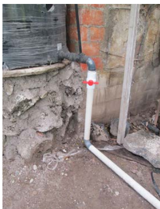
Foto 2 y 3: Base donde está montado el sistema colector de agua lluvia, octubre 2014. CEPRODE/GWP EL SALVADOR
