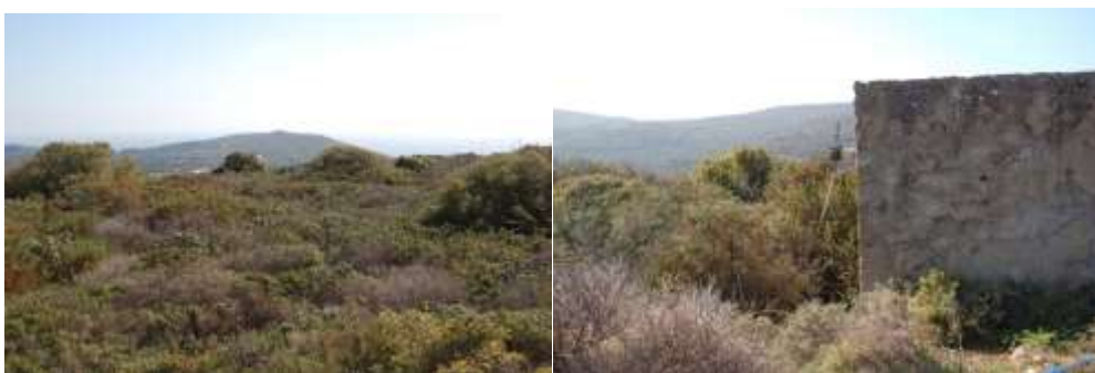
Εικόνα 2: Περιοχή Καλάμου Κυθήρων, χώρος τοποθέτησης νέας δεξαμενής (αριστερά) και ήδη υπάρχουσα δεξαμενή (60m 3 ) (δεξιά)
