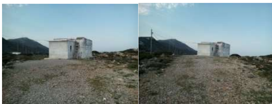
Εικόνα 3: Περιοχή Μύλοι Αντικυθήρων, χώρος τοποθέτησης νέας δεξαμενής και ήδη υπάρχουσα δεξαμενή (60m 3 )
