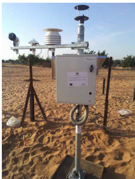
Station météo de Boumba (Commune de Falmey)
