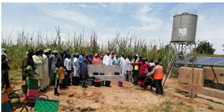
Poste d'Eau Autonome de Sénokonkedji (Commune de Tamou)
