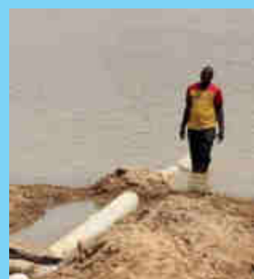
Prise d'eau station de pompage périmètre irrigué réhabilité de Boumba (Commune de Falmey)
