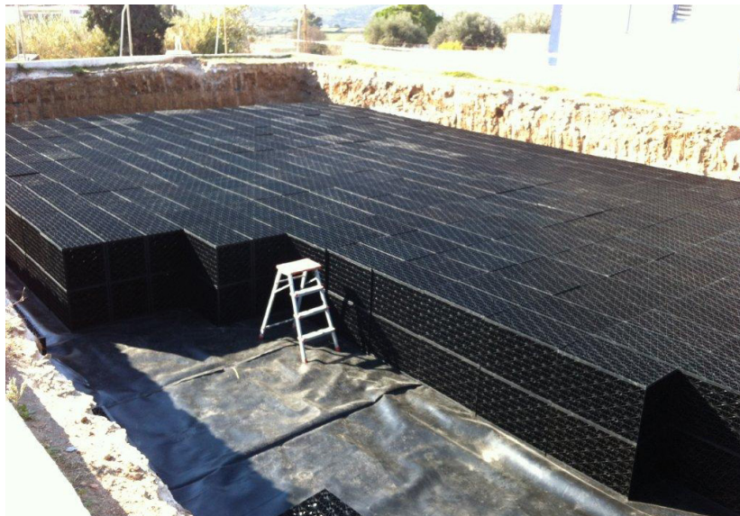
Εικόνα 7: Άνω: Εγκατάσταση αρθρωτής δεξαμενής στη Σύρο (πηγή: GWP-Med) Αριστερά: Συναρμολόγηση μονάδων αρθρωτής δεξαμενής (πηγή: GWP-Med)
