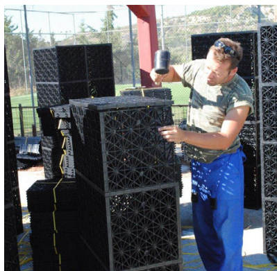
Εικόνα 7: Άνω: Εγκατάσταση αρθρωτής δεξαμενής στη Σύρο (πηγή: GWP-Med) Αριστερά: Συναρμολόγηση μονάδων αρθρωτής δεξαμενής (πηγή: GWP-Med)
