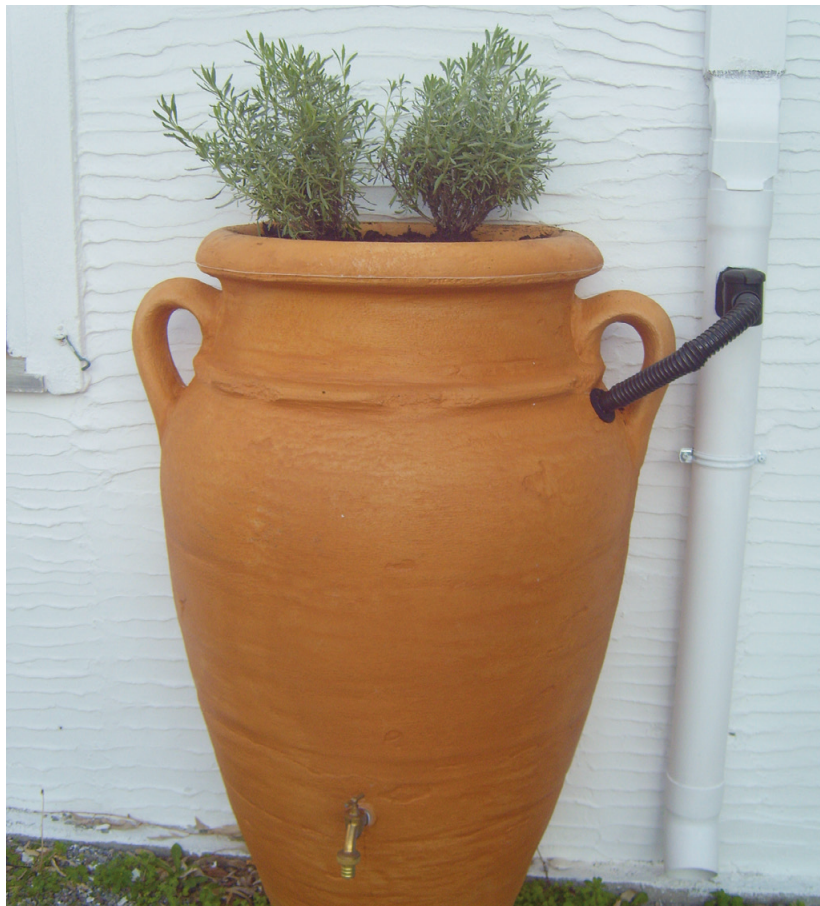
Εικόνα 5: Βαρέλι βροχής εγκατεστημένο σε νηπιαγωγείο στην Άνδρο (πηγή: GWP-Med)
