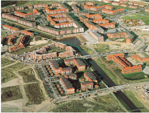
Figure 8.9: Aerial view of the Hamburg Allermöhe eco-settlement. © Hansesstadt Hamburg, Amt für Stadterneuerung
