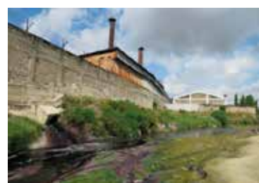
Plate 3.4. Nida Textiles Discharge
